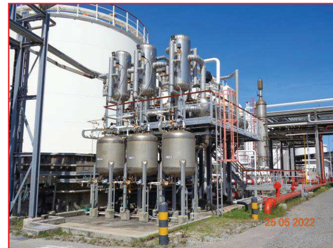
ภาพที่ 2.3-43 Vent Condensing Unit
