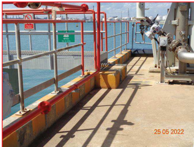
ภาพที่ 2.3-14 คั่นคอนกรีตล้อมรอบท่าเทียบเรือ
