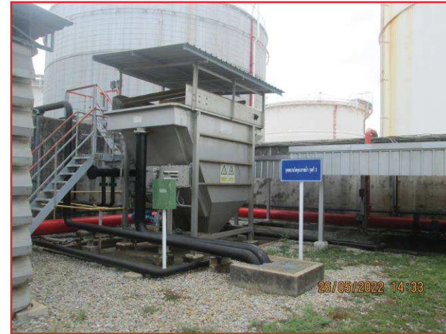
ภาพที่ 2.3-10 Oil-Water Separator
