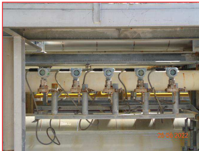
ภาพที่ 2.3-42 Pressure Transmitter
