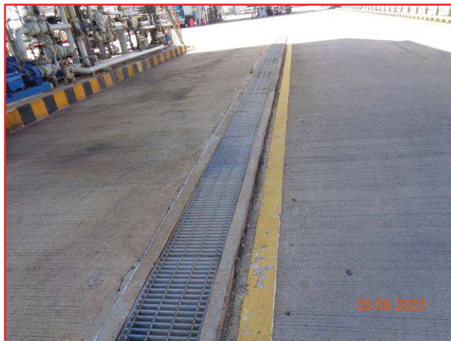
ภาพที่ 2.3-11 รางรองรับสารเคมีเมื่อเกิดการรั่วไหล
