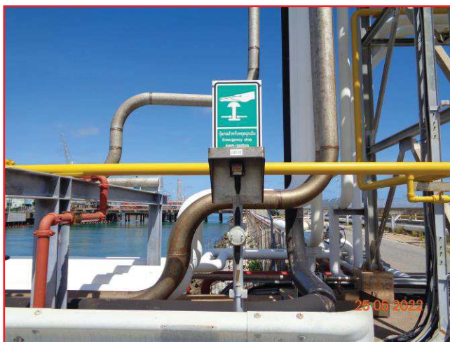
ภาพที่ 2.3-32 ปุ่มหยุดฉุกเฉินขณะ Load สารเคมี
