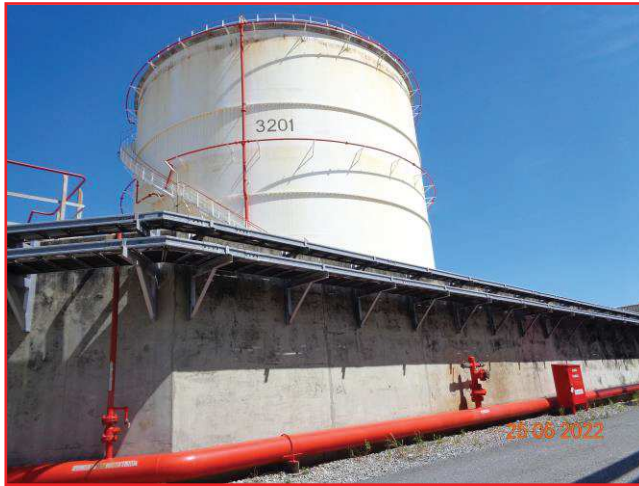
ภาพที่ 2.3-36 Bund Wall ของแต่ละกลุ่มถัง
